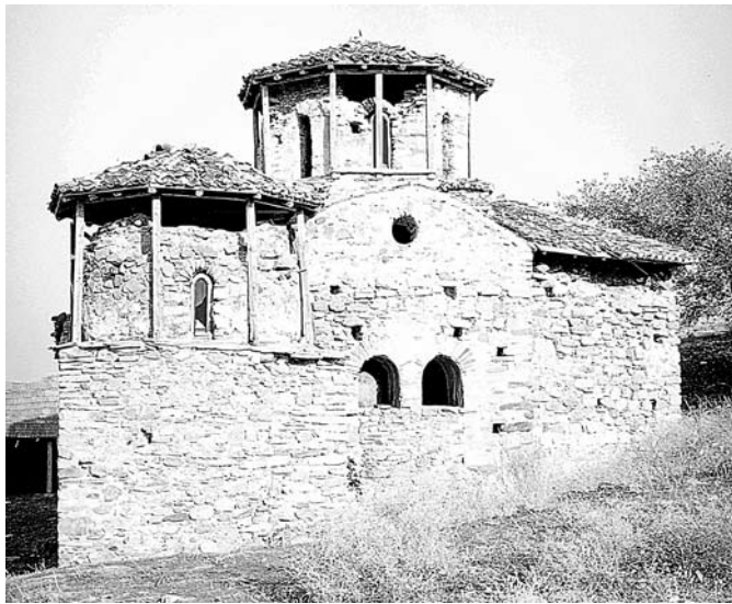
Сл. 2. Горњи Козјак, Свети Ђорђе, јужна фасада
